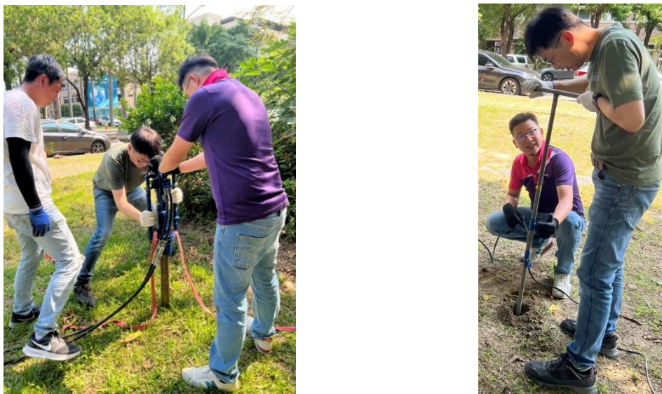
圖 40、現場施作照片 (左圖為油壓式鑽入；右圖為手動式鑽入)
