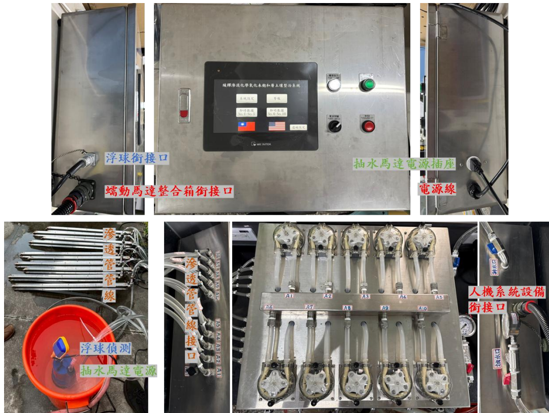
圖 29、滲透管與機電控制系統銜接測試
