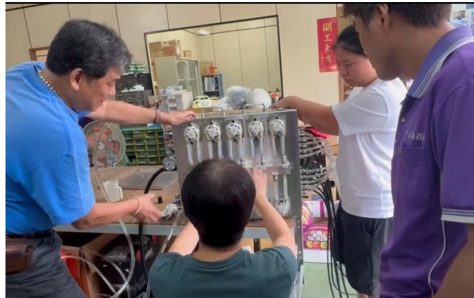
圖 26、於工廠訪視機電控制系統蠕動馬達整合箱設備建置情形
