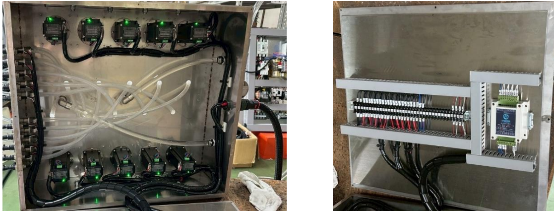
圖 28、機電控制系統蠕動馬達內部構造
