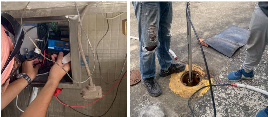
圖 56 建置 TDR 監測系統與 TDR 監測感測器
