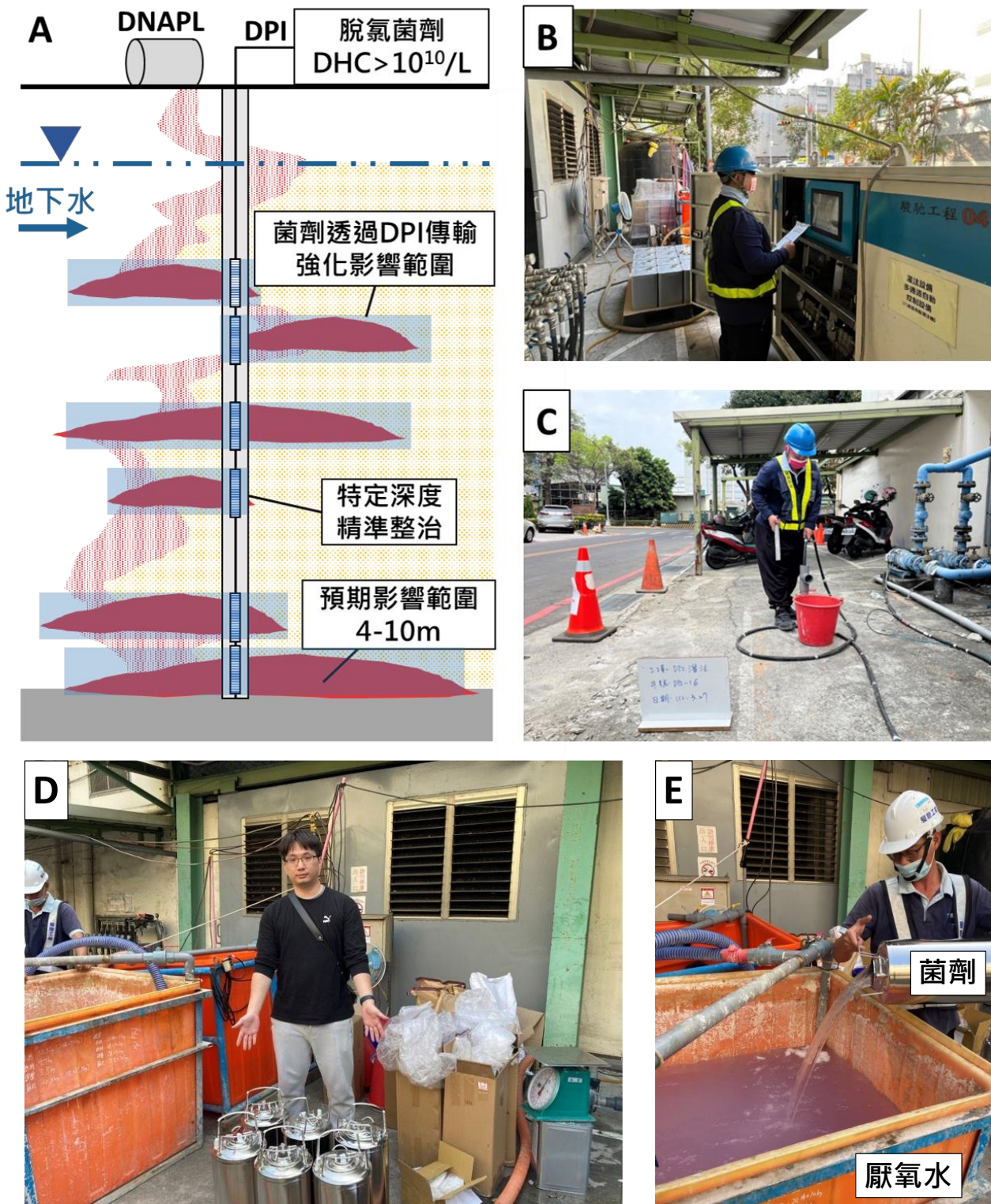
圖 16. (A) 脫氯菌劑 DPI 灌注工法示意圖; (B) DPI 灌注設備操作圖; (C) DPI 菌劑灌注深度調整施工照; (D) 脫氯菌劑菌劑現地施作圖; (E) 以厭氧水保護脫氯菌劑進行 DPI 灌注工法
