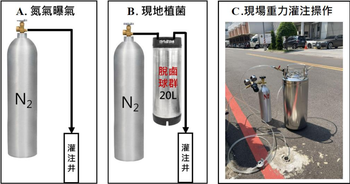
圖 17.重力灌注工法(A) 透過氮氣曝氣將現地地下水調整為厭氧環境；(B) 現地植菌；(C) 脫氯球菌菌劑現場施作圖
