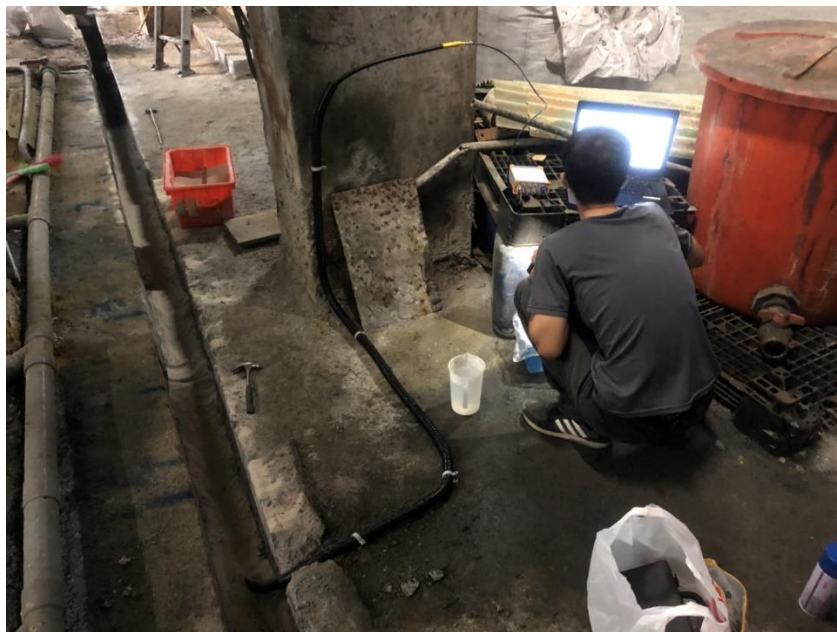
圖 28 溝渠監測纜線安裝與洩漏試驗
