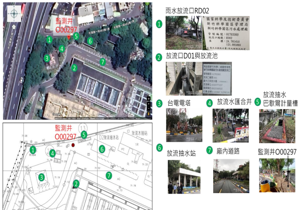
圖4.3-9 模場區域現場現勘照片
