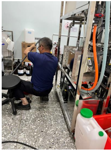
圖 二十、硬體工程師正加裝裝置硬體設備
