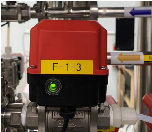
圖 十一、電動閥正常開啟之狀態(亮綠燈)
