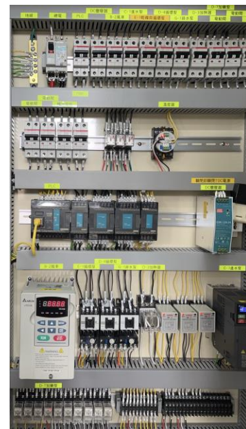
圖 十八、吸附及再生自動化設備(a)設定及(b)電路系統之介面
