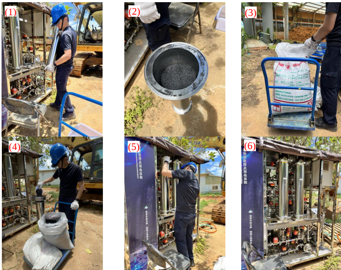
圖 四十三、更換氣體用柱狀活性碳為液體用顆粒狀活性碳之全過程
