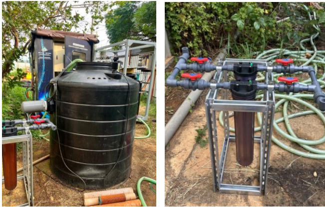
圖 四十五、設置中繼桶及簡易過濾裝置
