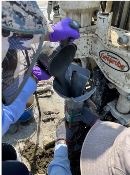
圖 27 土壤與生物碳混合均勻回填
