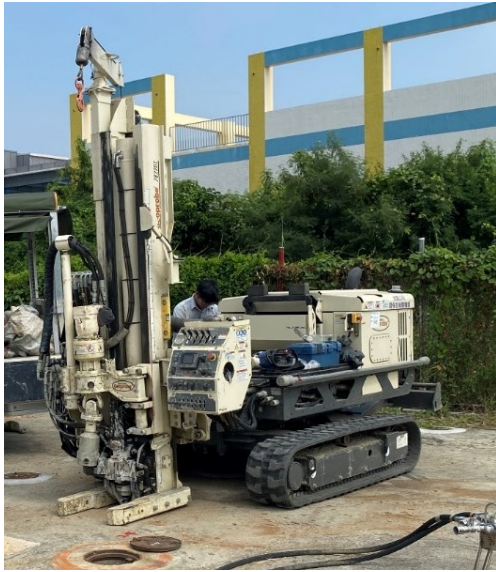
圖 22 Geoprobe® 7822DT 地質鑽探機
