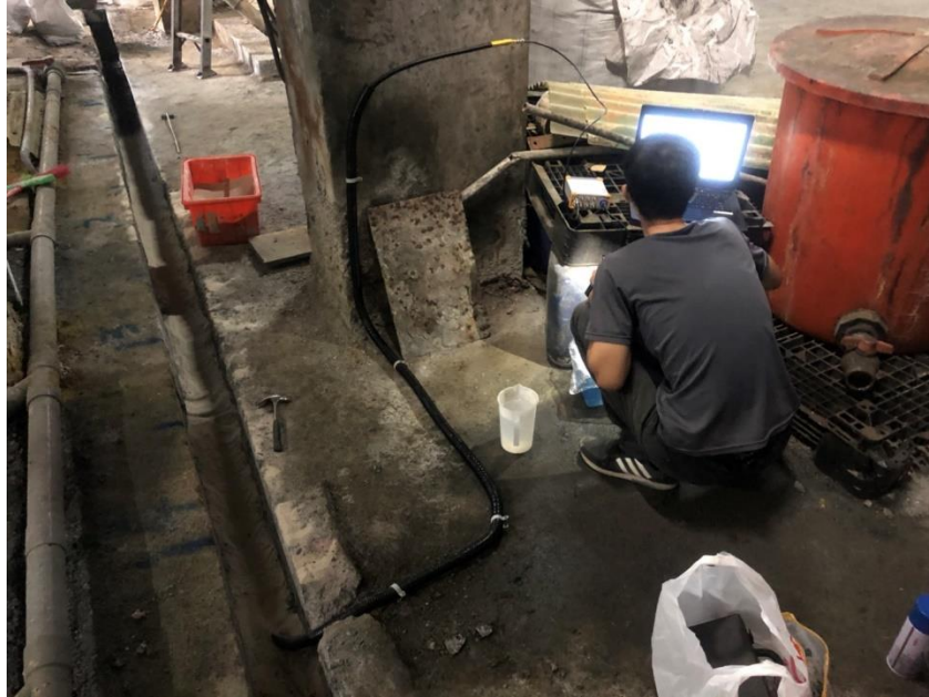
圖 27 溝渠監測纜線安裝與洩漏試驗
