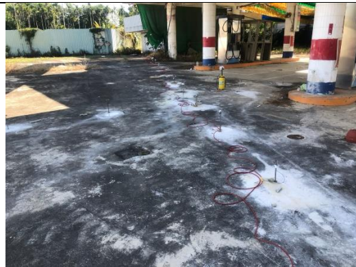
圖 50 電極洗孔照片圖
