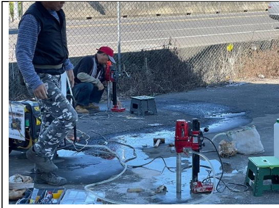
圖 50 電極洗孔照片圖
