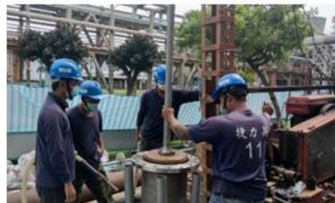
井內阻隔系統(阻隔版)安裝作業
