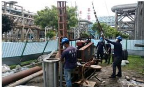
井內阻隔系統(阻隔版)安裝作業
