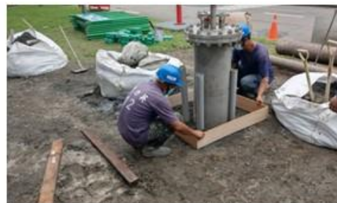
水泥平台設置作業
