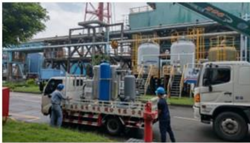
防爆設備及電箱安裝作業
