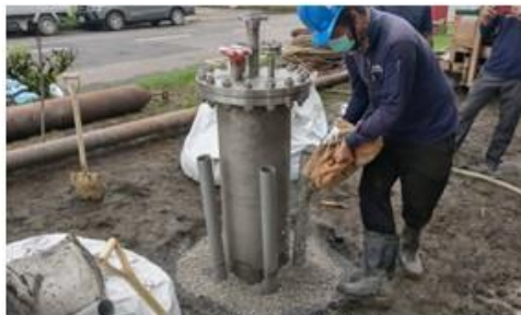
水泥平台設置作業
