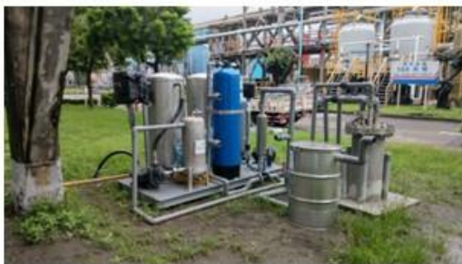
防爆設備及電箱安裝作業
