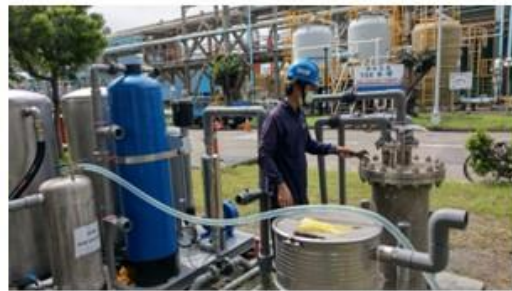
設備測試作業
