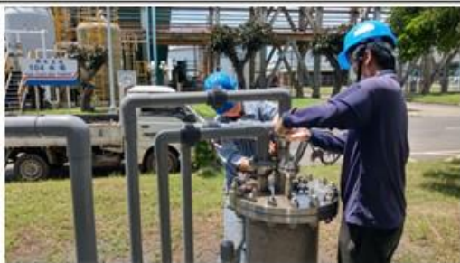
設備測試作業
