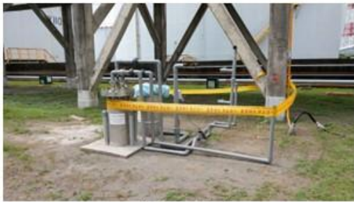
設備拆除離廠
