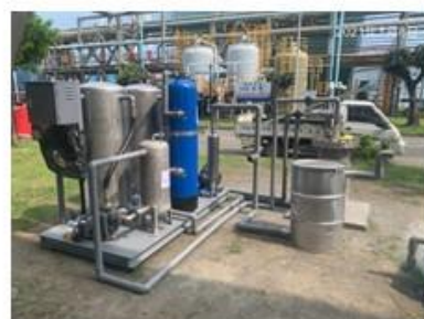
設備管線配置作業
