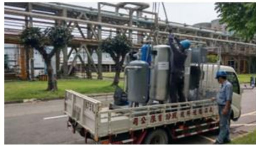
設備拆除離廠
