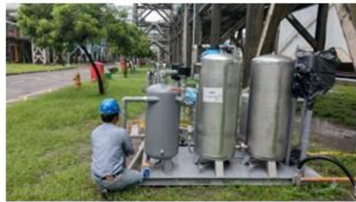
防爆設備及電箱安裝作業
