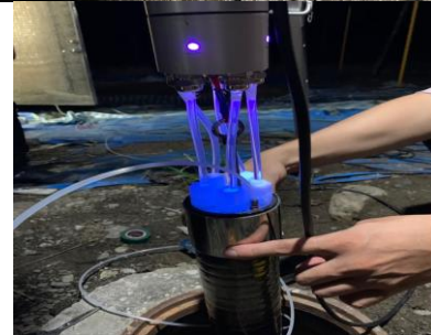
圖 16、光纖光催化系統放置處理井施工圖
