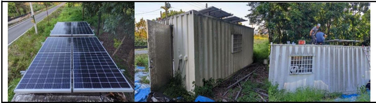
圖 46、太陽能綠能設備架設現場照片
