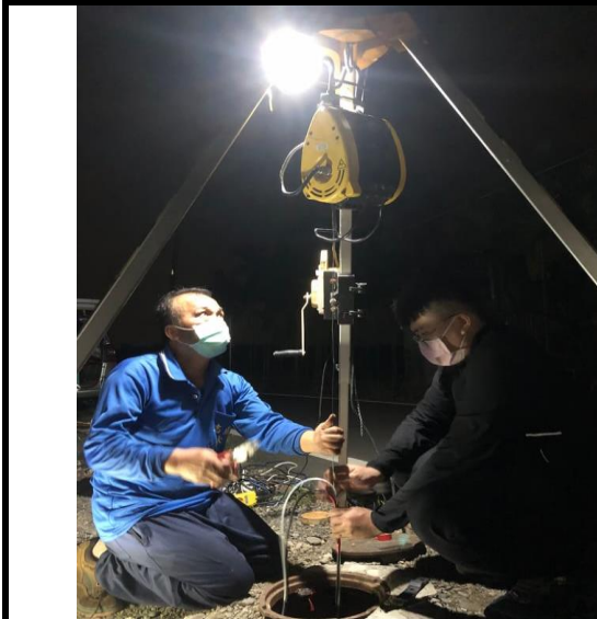
圖 16、光纖光催化系統放置處理井施工圖
