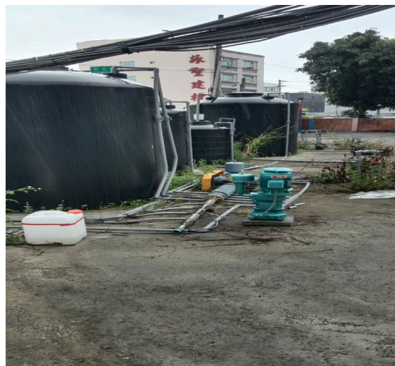
圖 3.10 廢水處理設施鼓風機設備完工
