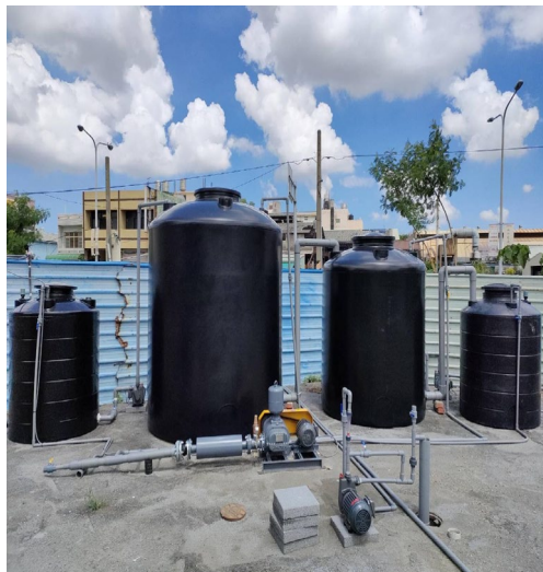
圖 3.10 廢水處理設施鼓風機設備完工
