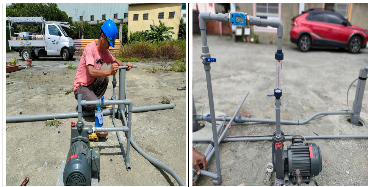
圖 3.4 抽水馬達安裝完工圖
