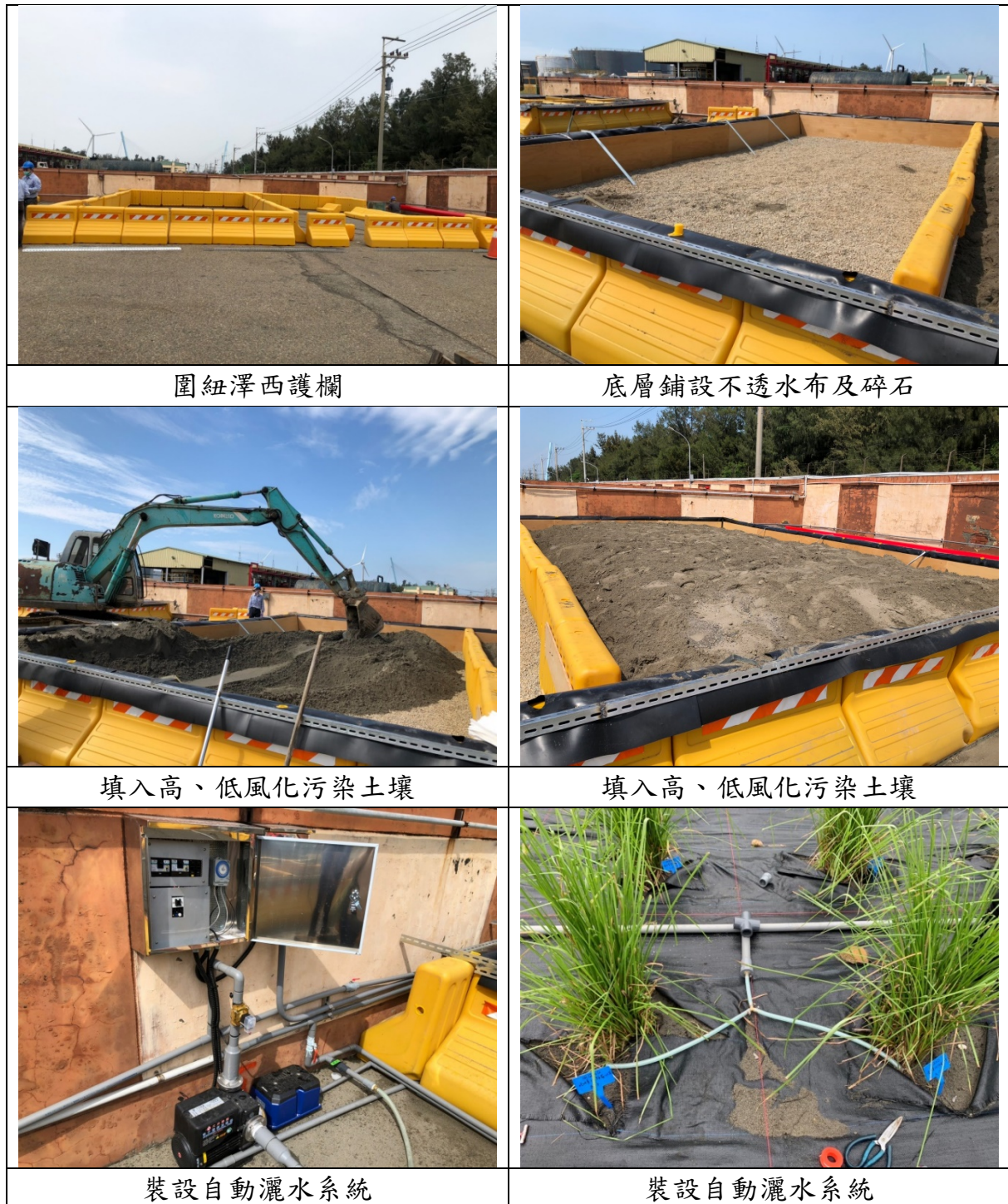
圖3.1-3 現地模場試驗場址設置情形
