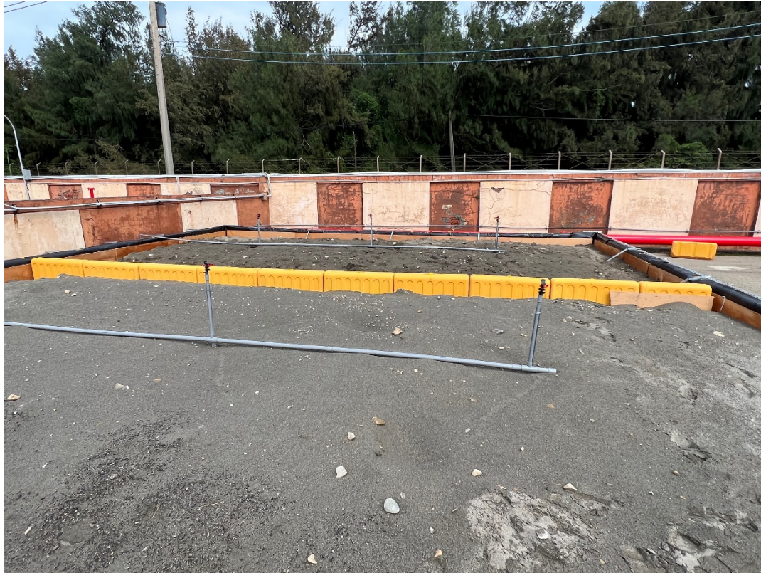
圖3.1-4 現地模場試驗場址設置情形
