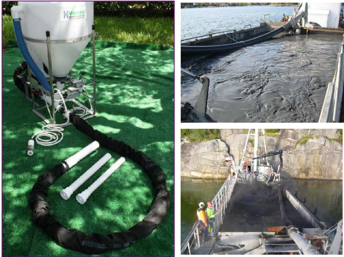
圖 3-6、噴灑式薄層覆蓋工法之施作設備
