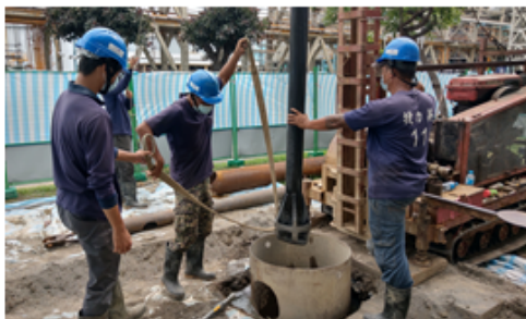
以傳統衝擊鑽機進行鑽探作業
