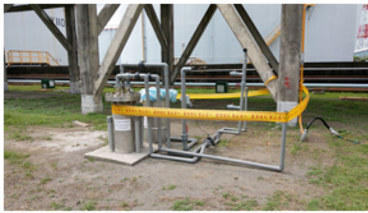
設備拆除離廠
