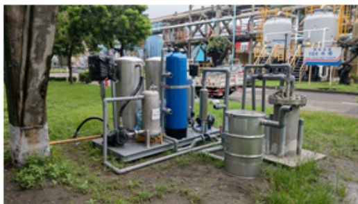
防爆設備及電箱安裝作業
