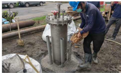
水泥平台設置作業
