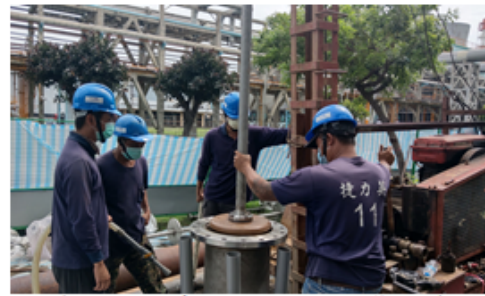
井內阻隔系統(阻隔版)安裝作業
