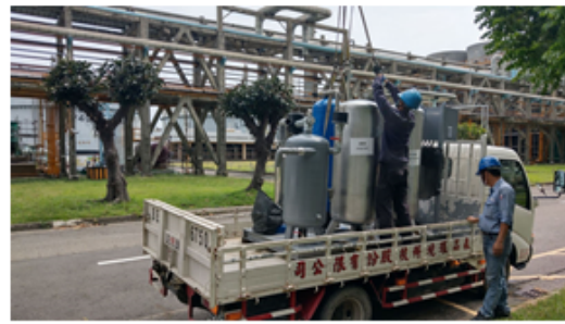
設備拆除離廠
