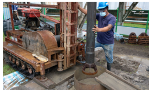
鑽孔擴孔作業
