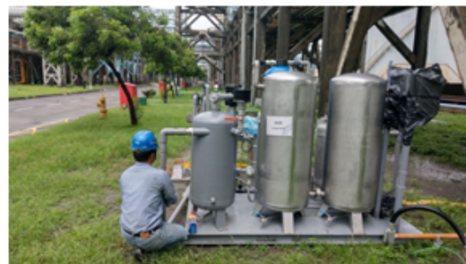
防爆設備及電箱安裝作業
