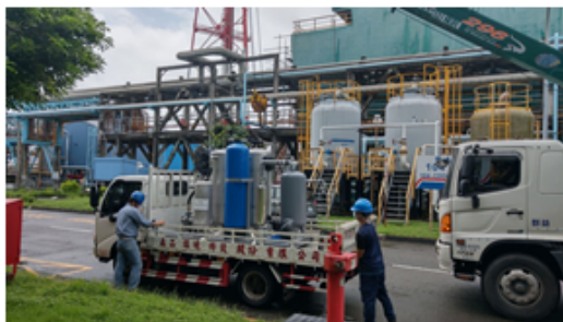
防爆設備及電箱安裝作業
