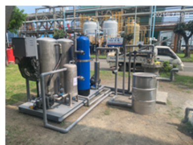
設備管線配置作業
