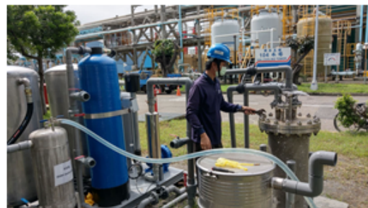
設備測試作業
