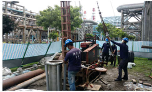
井內阻隔系統(阻隔版)安裝作業
