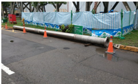
現場施工圍籬及井管
