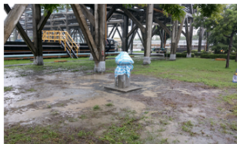
現場環境整理
