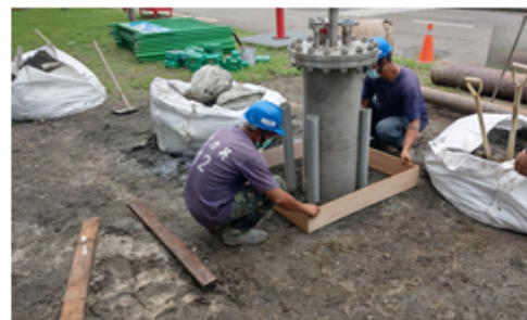
水泥平台設置作業
