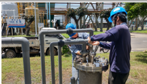
設備測試作業
