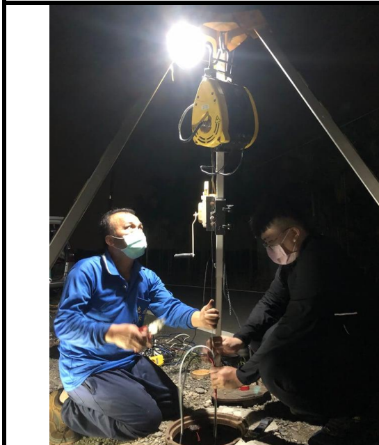
圖 22、光纖光催化系統放置處理井施工圖
