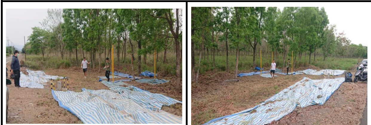
圖 9、現地模場整地作業(整理後)
