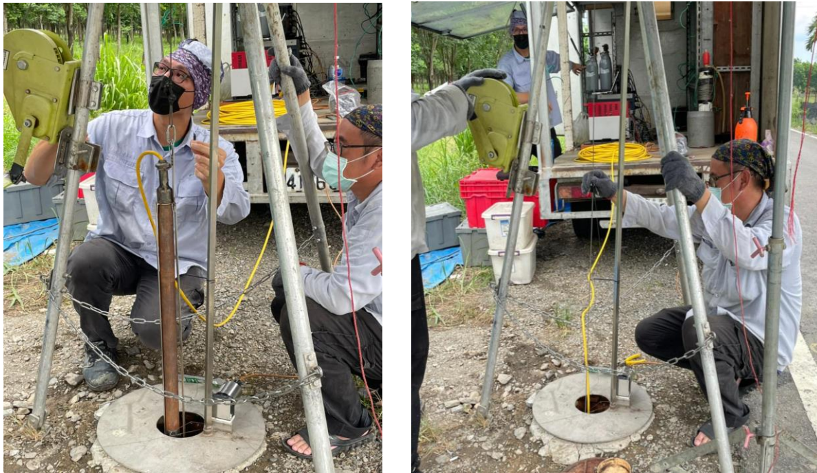
圖43、MIP組裝及現場作業
