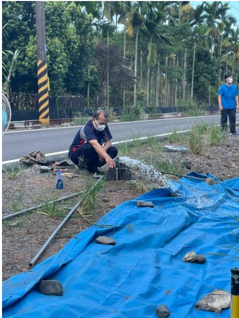
圖 14、現地模場系統/觀測井之洗井作業
