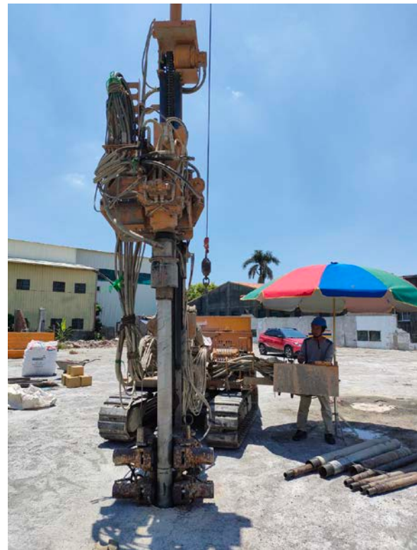
圖 3.2 污染整治區鑿井施工圖
