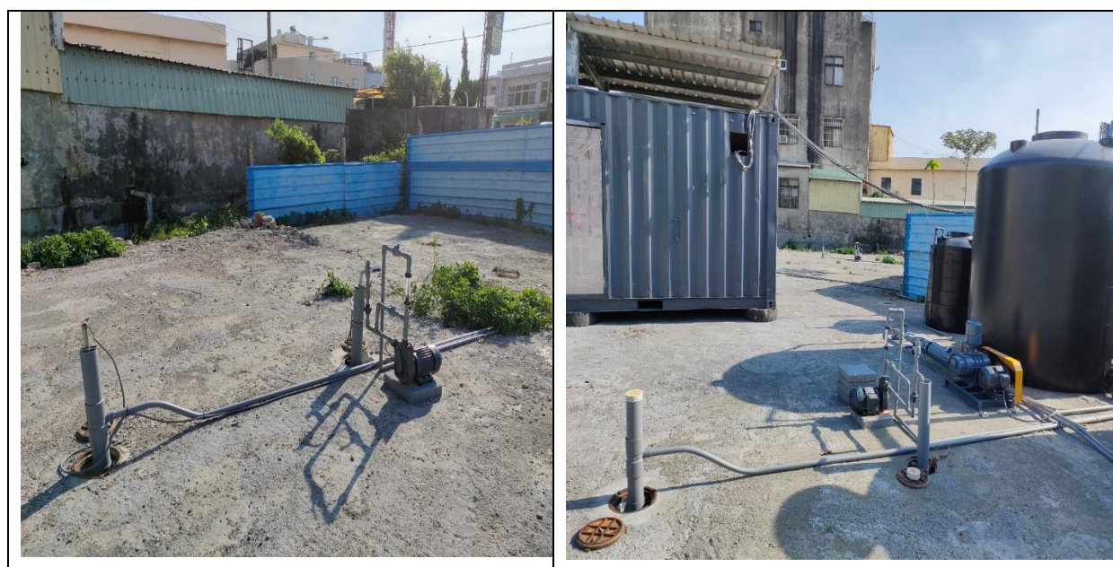
圖 3.5 抽水馬達安裝完工圖
