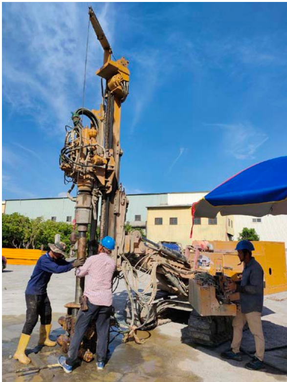
圖 3.2 污染整治區鑿井施工圖
