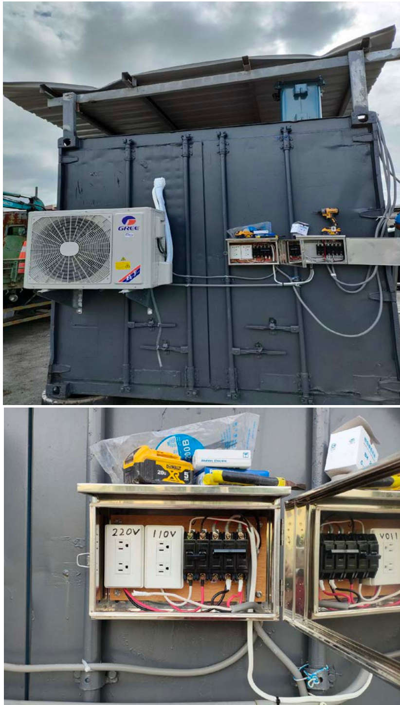
圖 3.8 電力設備安裝完工圖-3
