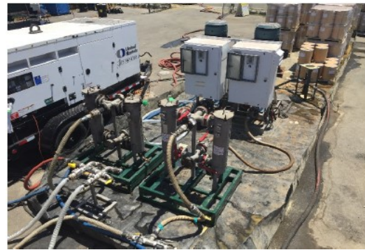
圖 8 藥劑注入設備設置
