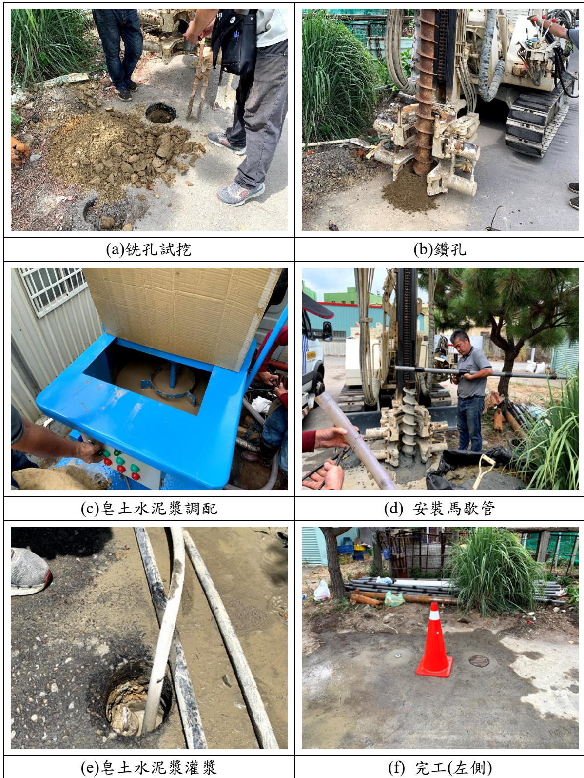
圖 35 雙封塞灌注井施工情形
