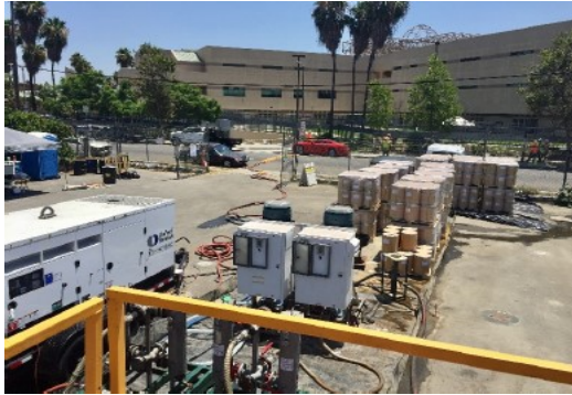
圖 7 現場設備設置
