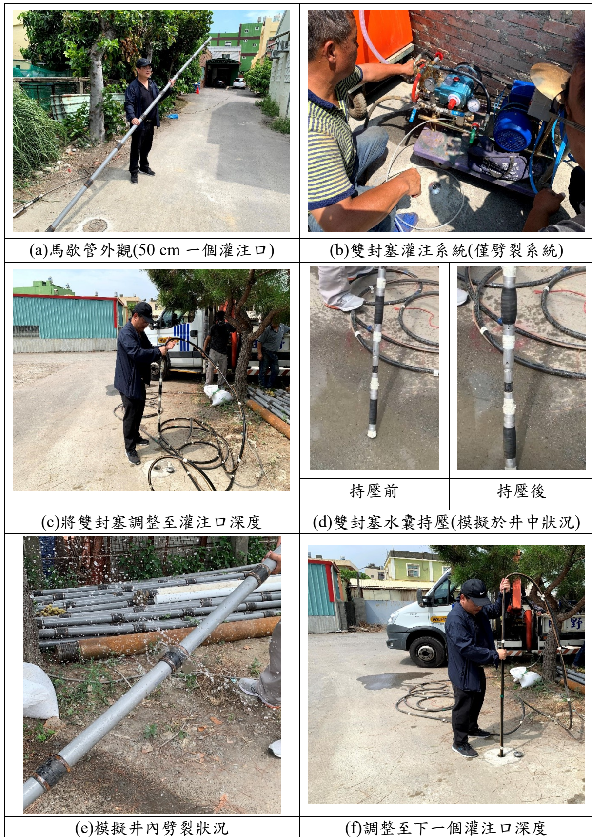
圖 36 雙封塞灌注井劈裂作業狀況
