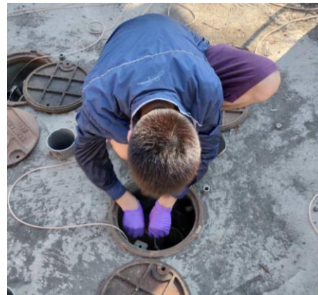
圖 36.電極井電線配置
