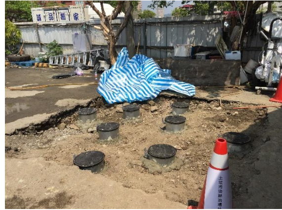
圖 32.地下水井套筒安裝
