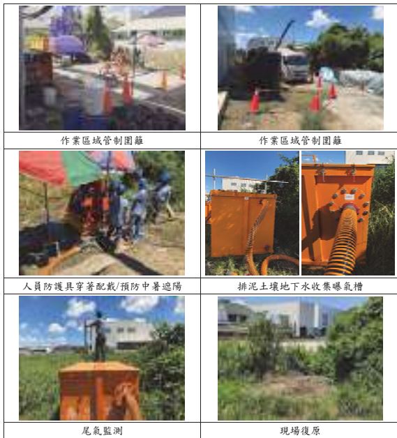
圖2、現場作業場址衛生安全相關照片
