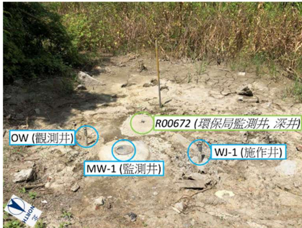
圖 4.5.1-3、水刀注藥施作後現場照片
