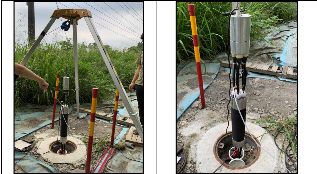
圖 44、光纖光催化系統放置處理井施工圖
