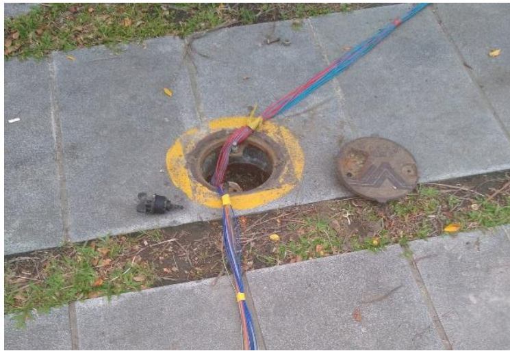
圖 30 YEW-2 感測器孔內安裝完成圖
