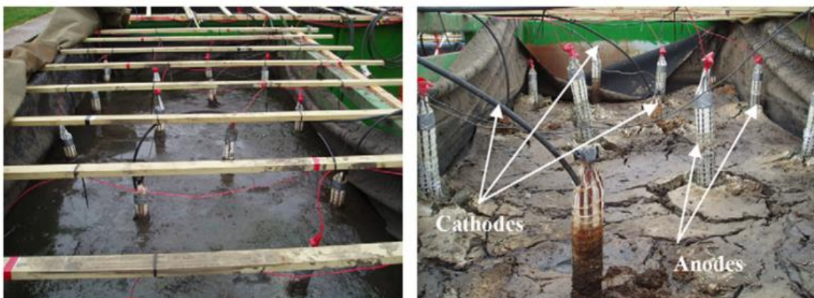
圖 21 電動力法進行污泥脫水(a)處理前；(b)處理後 [34]
