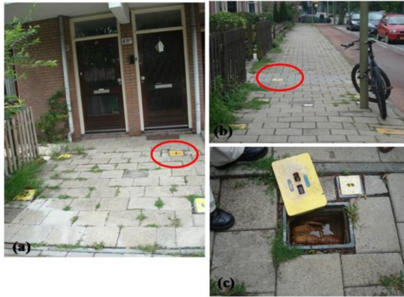
圖 16 荷蘭住宅電動力裝置(a)住家門口；(b)人行道；(c)電極孔
