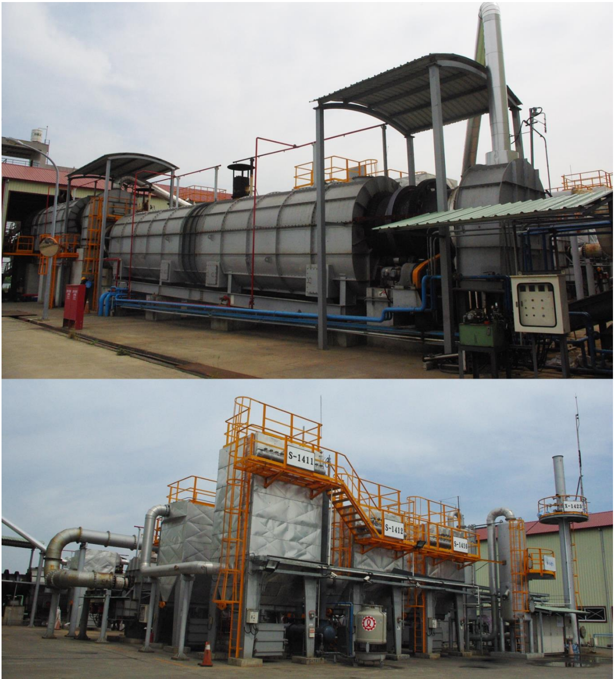
圖 5.2.3-1 現場熱處理(上：分批式燃燒室；下：後段尾氣處理設施)
