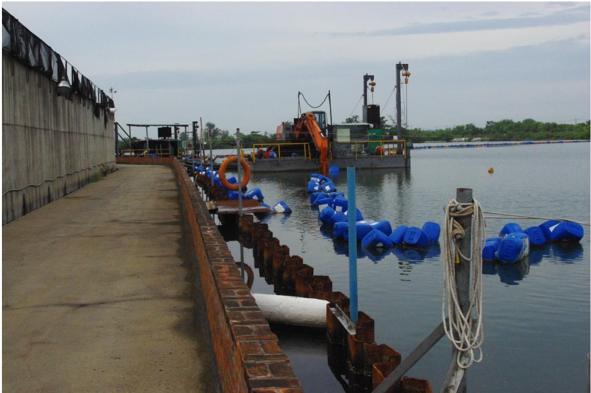
圖 5.2.2-1 廠區內設置圍堤以避免污染源再次流入水域
