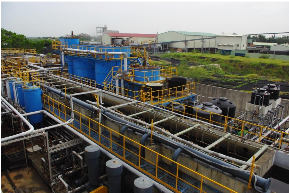
圖 5.2.2-4 設置廢水淨水廠，處理抽出污染底泥之廢水
