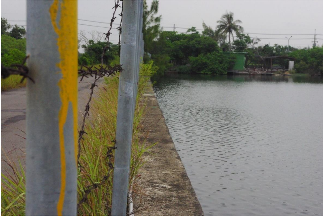
圖 5.2.1-1 場址周邊設置的鐵網圍籬，並置監視系統監控
