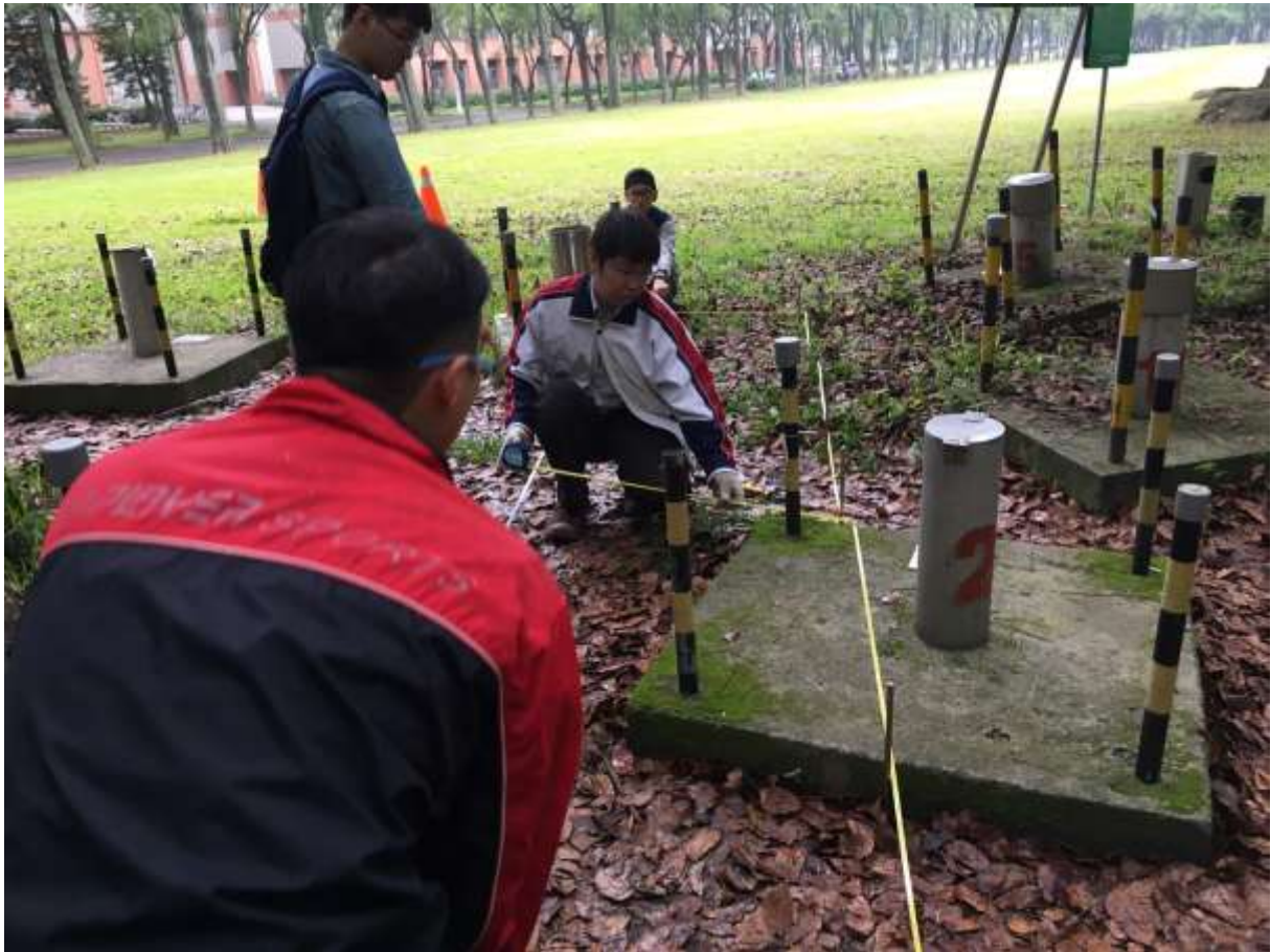
圖 4-11、五測線地電阻設置現場照片(1/2)
