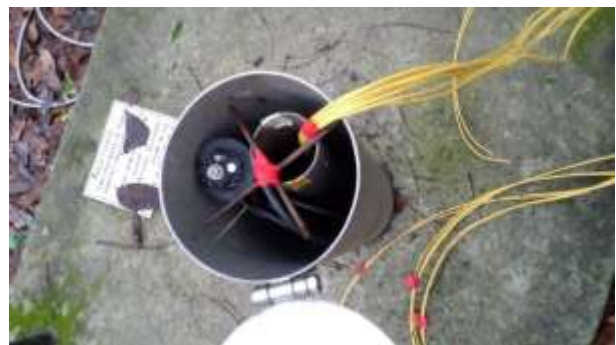
圖 4-15、自製導電度計設置井中照片
