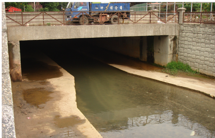
圖 4.3 磺港溪於延壽橋下出口
