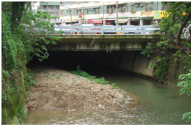
圖 4.2 磺港溪於薇閣國小後進入地下之入口
