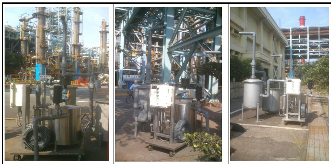
圖 5.9 F 區第六媒組工場周界污染局限工法 SVE/AS 系統設置
