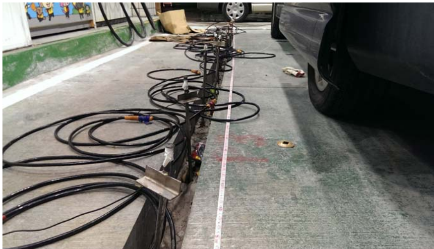
圖189、刨除干擾物（RC 結構），電極棒可完全接地示意圖
