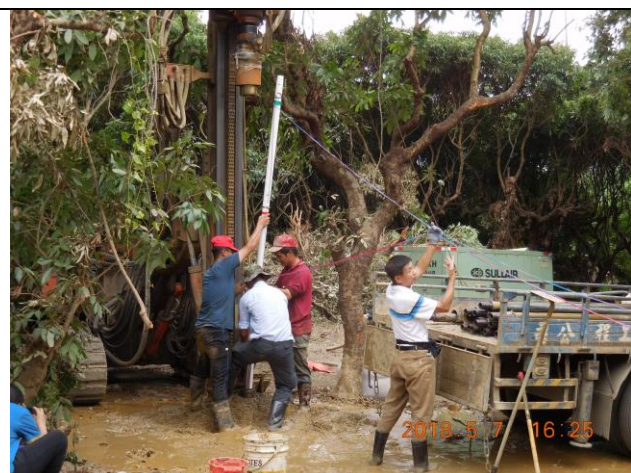
監測井結合地球物理探測井管下管 (2018.05.07)
